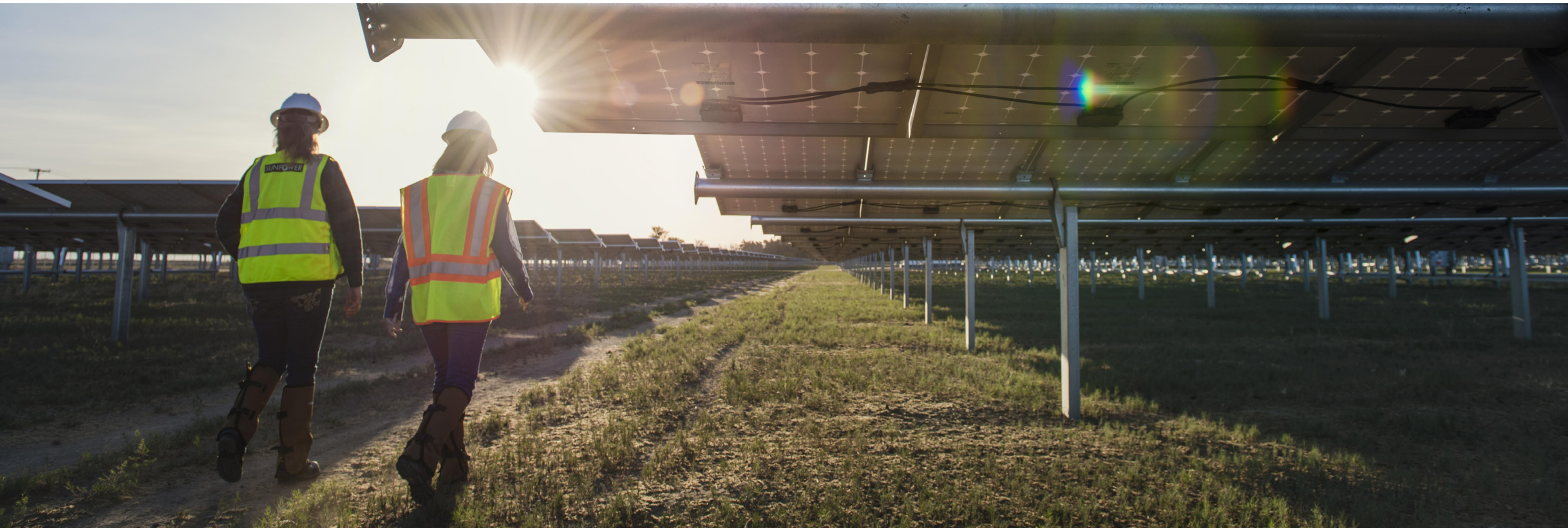
© DAVID LAURIDSEN Paneles solares en la planta fuller Star en Lancaster, California.
